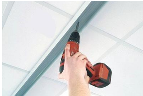
Fixation sous plafond existant
