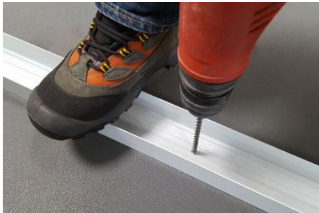
Fixation au sol du rail ALU
